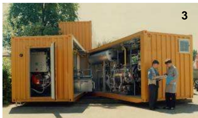
3 Контейнерная котельная установка с двумя термомасляными котлами Газпром / Россия
