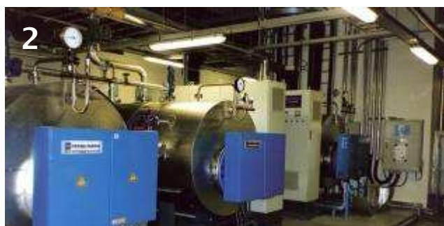
2 Генераторы чистого пара для производства компьютерных чипов Вануард, Тайвань
